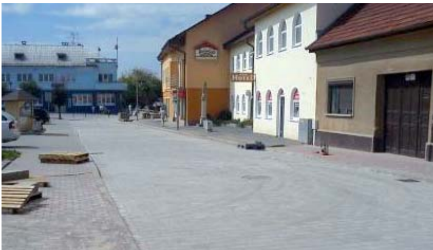
Zrekonštruovaná Jesenského ulica
